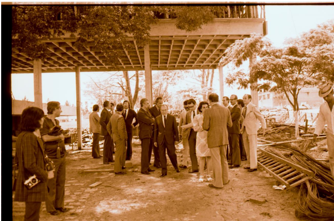
Reitor Miguel Reale e comitiva em visita à construção do Centro de Processamento de Dados
