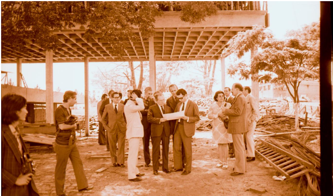
Visita à construção das futuras instalações do Centro de Processamento de Dados - CPD. À frente: diretor Morency Arouca e prof. José Savério Lia apresentando o projeto ao reitor Miguel Reale e, ao lado, prof. Romeu Corsini
