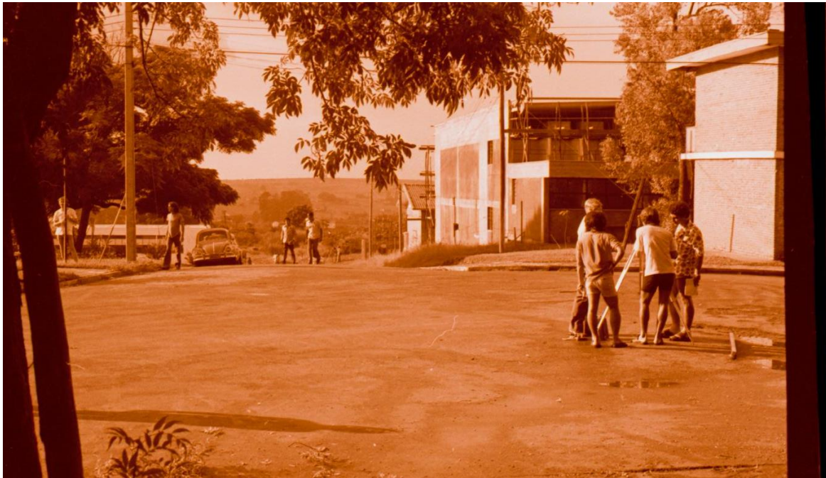
Alunos durante aula de topografia ao lado do Alojamento e da Biblioteca da EESC em fase de construção, em 26/02/1972
