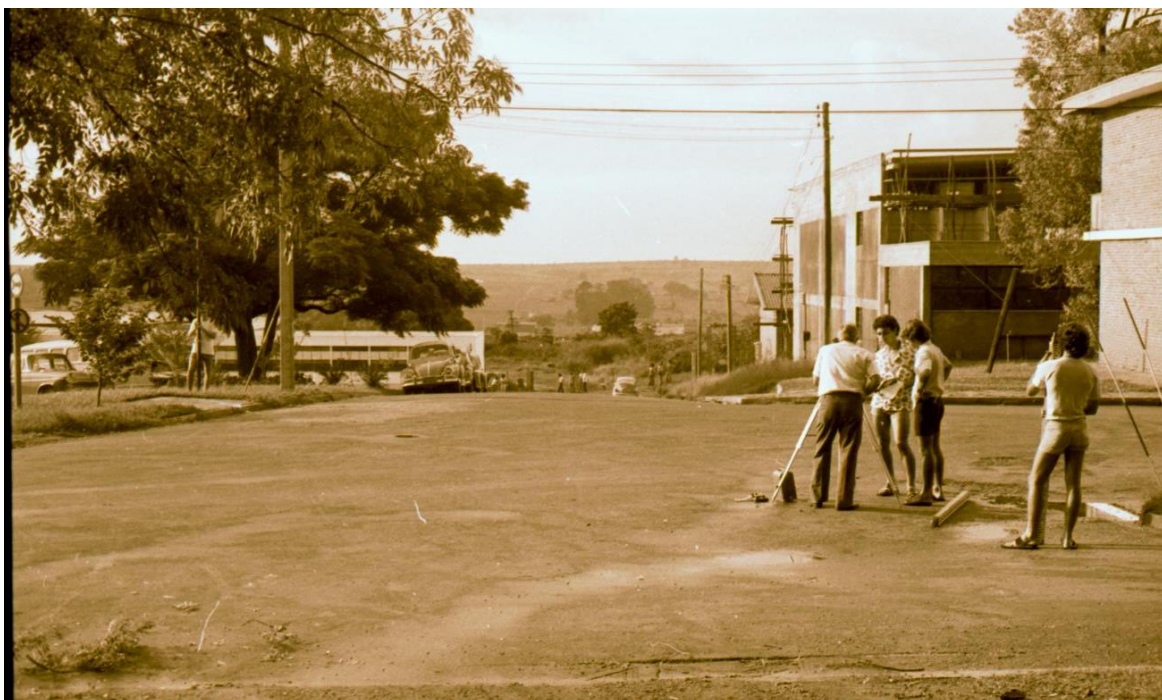
Alunos durante aula de topografia ao lado do Alojamento e da Biblioteca da EESC em fase de construção e, ao fundo, o prédio do CAASO em 26/02/1972
