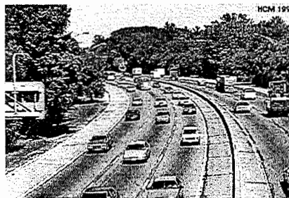
Fig. 3.22: Nível de serviço E
