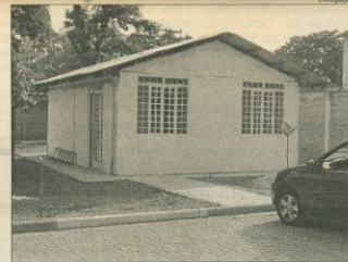
Kit paltreiro: casa é feita através de bases e parede de gesso, em Descalvado moradores já fazem uso deste tipo de moradia
