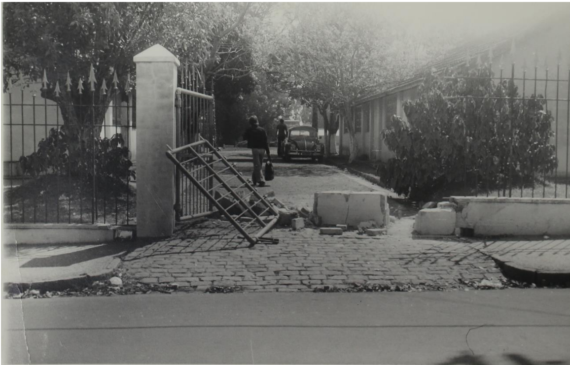
Entrada principal ao Campus pela Av. Dr. Carlos Botelho, nº 1465, danificada.
