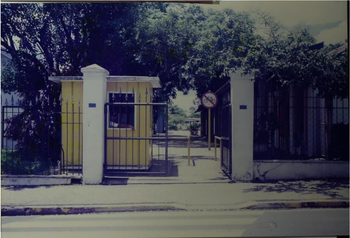
Entrada de pedestres pela Av. Dr. Carlos Botelho com guarita de segurança. 1999
