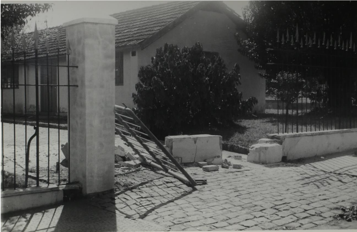
Entrada principal ao Campus pela Av. Dr. Carlos Botelho, nº 1465, danificada por um acidente de veículo em 25.08.1978.
