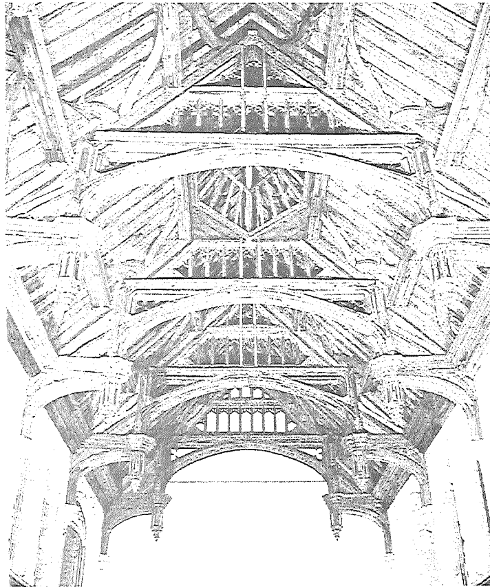
Figura 1.5 – Cobertura gótica em madeira, construída em 1405.
