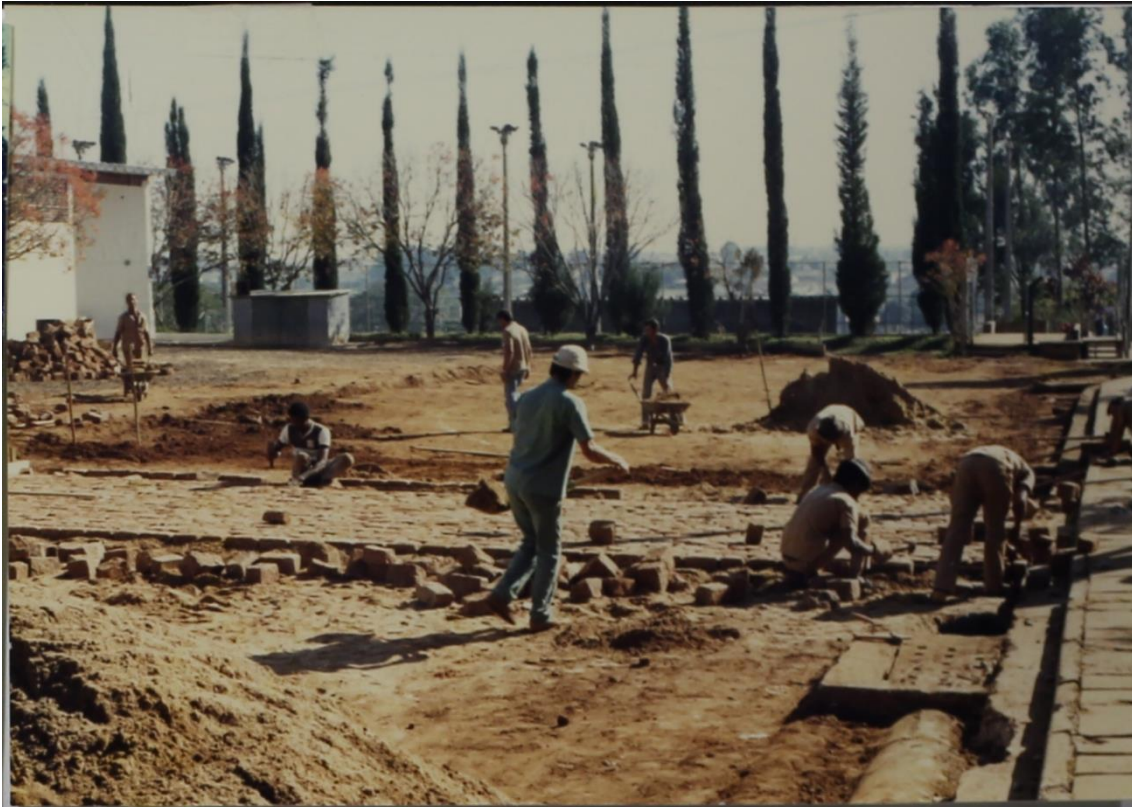
Foto 1 - Calçamento da rua entre o CAASO e o Bloco C tendo ao fundo as quadras esportivas em 1989.
