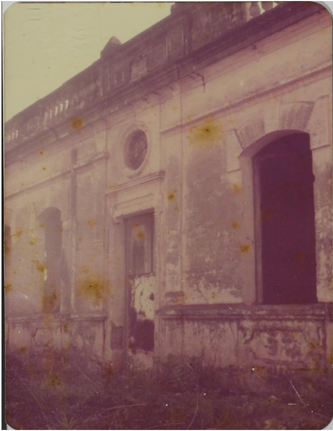
Foto 1 - Entrada do prédio antigo do Matadouro de São Carlos.
