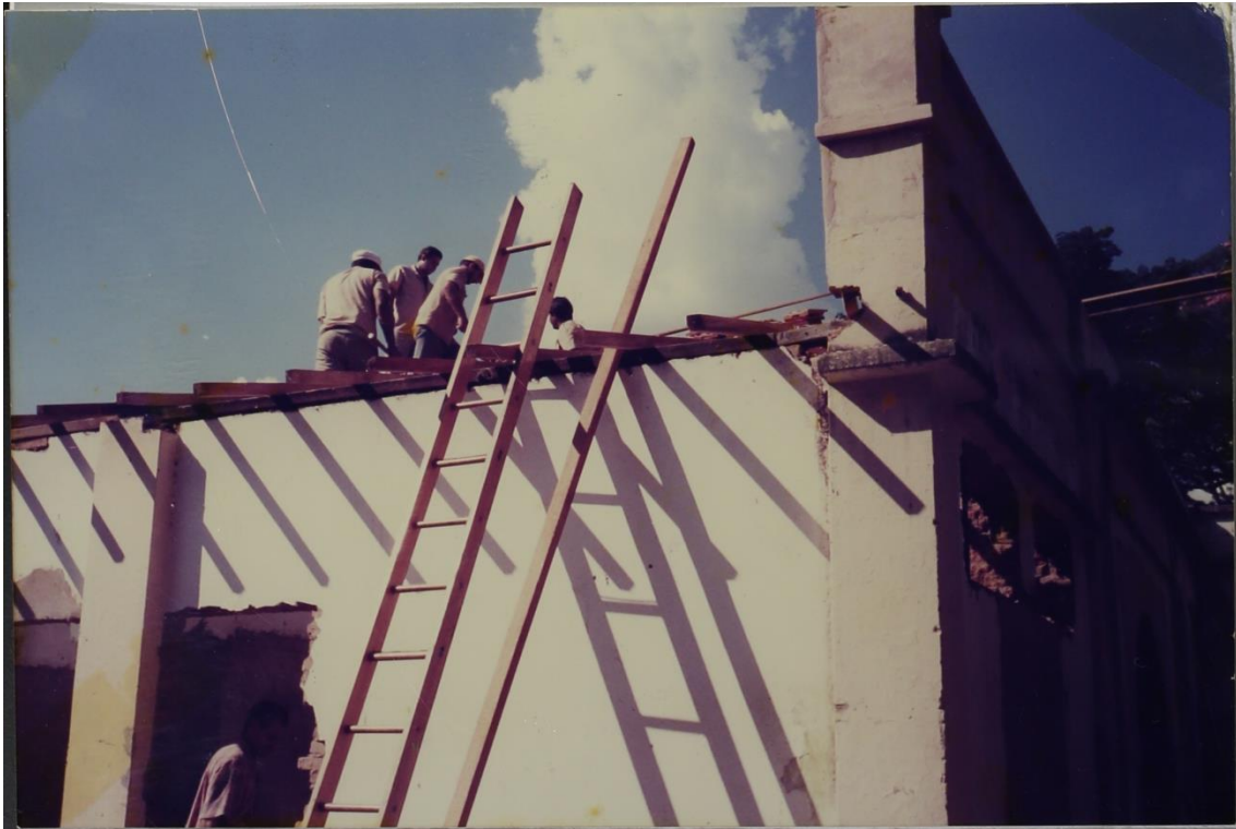
Foto 5 - Recuperação e troca do telhado do antigo Matadouro Municipal
