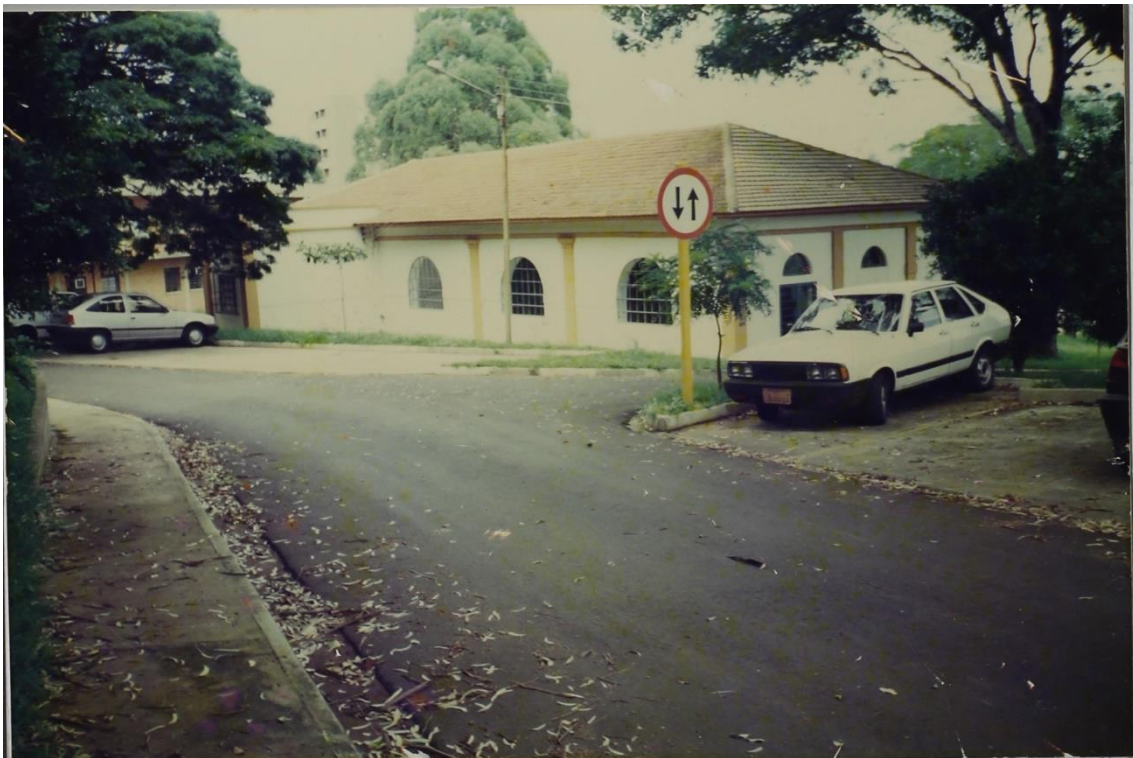
Foto 10 - Antigo Matadouro municipal de São Carlos que foi reformado e transformado em sala de aula.
