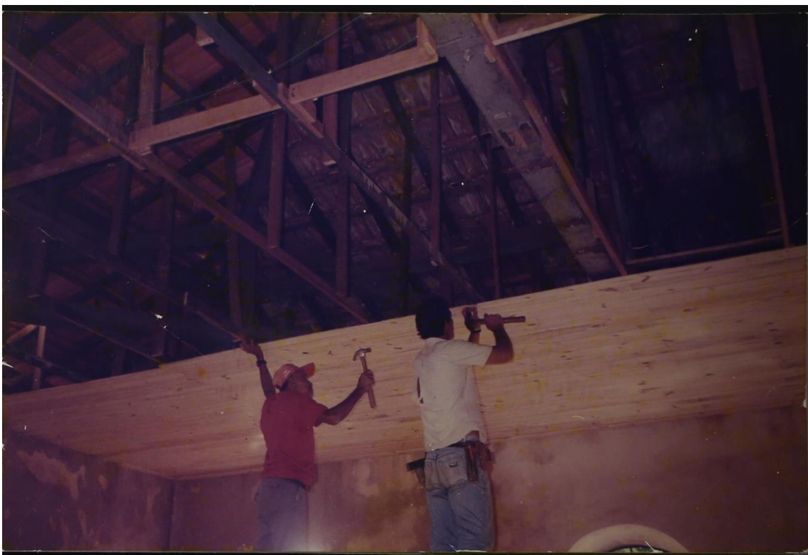
Foto 8 - Reforma e colocação de forro no antigo Matadouro Municipal
