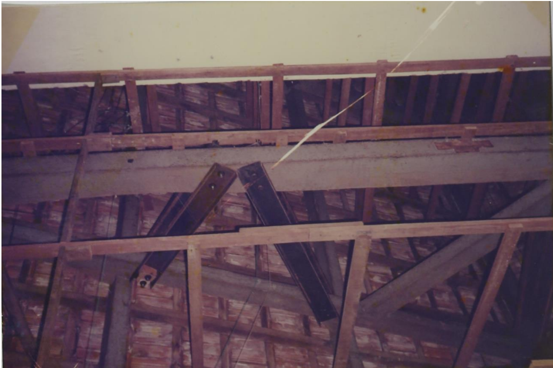
Foto 7 - Reforço das vigas internas do telhado
