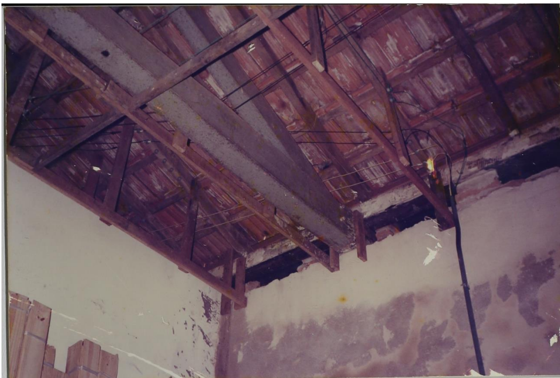
Foto 6 - Reforço das vigas internas do telhado
