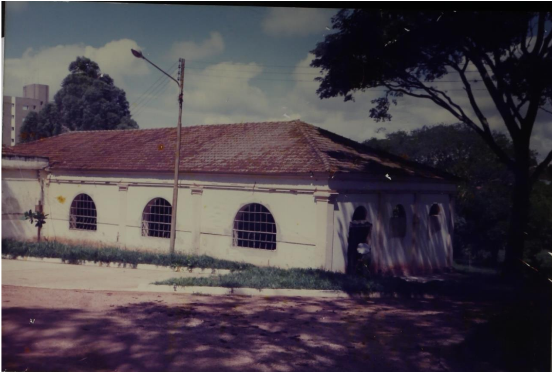
Foto 9 - Prédio do antigo Matadouro Municipal em reforma
