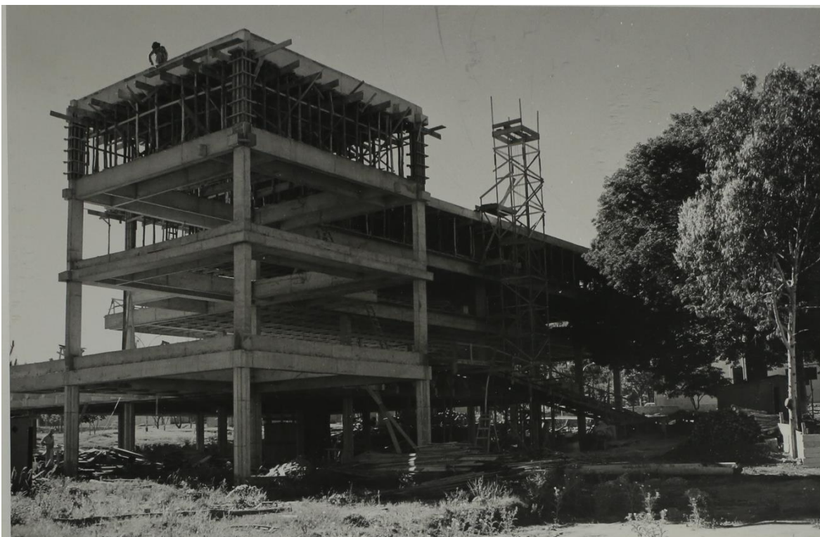
Novo prédio do CPD em construção
