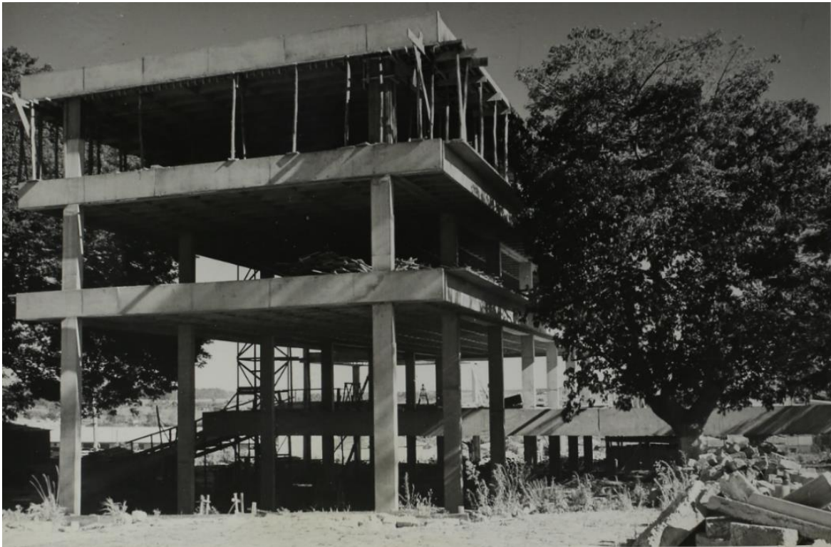
Novo prédio do CPD em construção, década de 70
