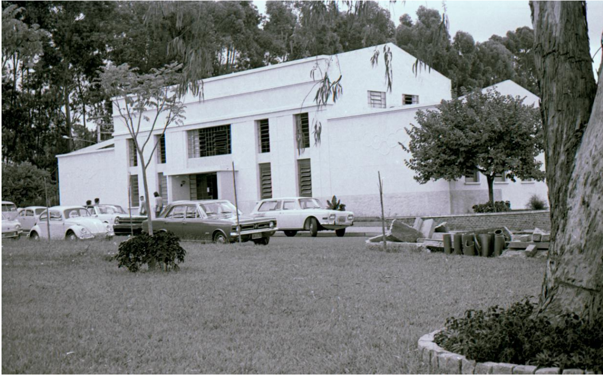
Fachada do Centro de Processamento de Dados - CPD em 1967
