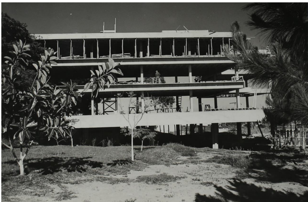
Construção do novo prédio do Centro de Processamento de Dados, década de 70
