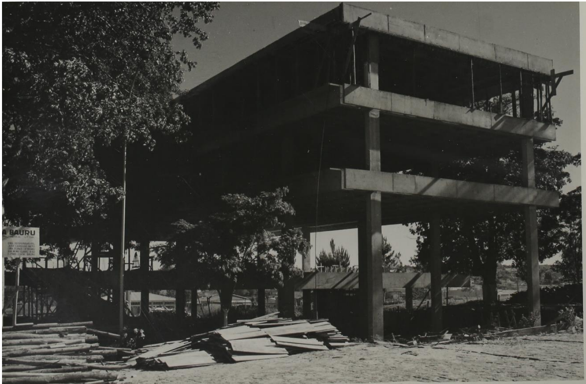
Construção do novo prédio do Centro de Processamento de Dados
